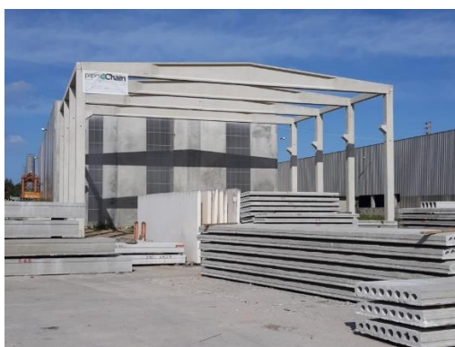
Figura 29: Pabellón industrial. Proyecto Paperchain en Aveiro (Portugal). Fuente: www.tehagoeco.com/paperchain-un-ejemplo-de-simbiosis-industrial/
